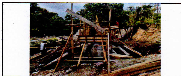
ENCOFRADO DE CONCRETO CICLOPEO
