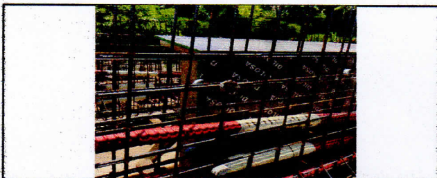
POLIDUCTO PARA CABLES PARA TENSAR
