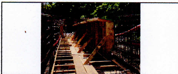
ENCOFRADO DE VIGAS POSTENSADAS
