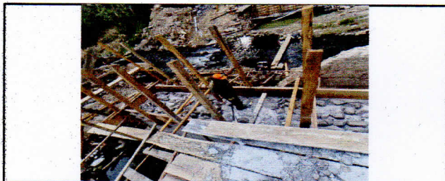
FUNDICIÓN DE CONCRETO CICLOPEO PARA ESTRIBO
