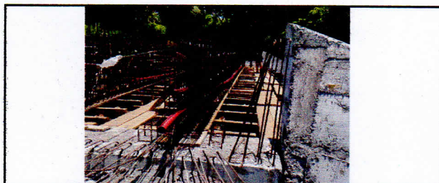
ARMADO DE VIGAS POSTENSADA CON POLIDUCTO PARA CABLE A POSTENSAR
