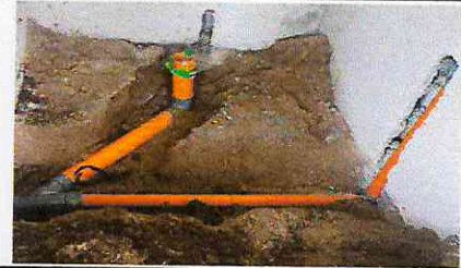
INSTALACION DE TUBERIA DE DRENAJE
