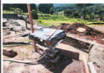
ZANJA PARA LODOS DE BENTONITA
