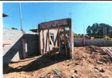
CONSTRUCCION DE CASETA DE BOMBEO
