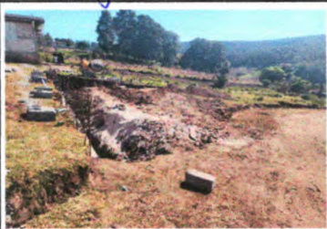
TRAZO, REPLANTEO Y EXCAVACIÓN DE ZANJA PARA MURO DE CIRCULACIÓN
