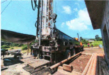
PERFORACIÓN DE POZO
