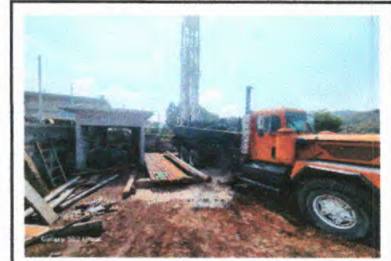
MONTAJE, NIVELACION DE MAQUINARIA
