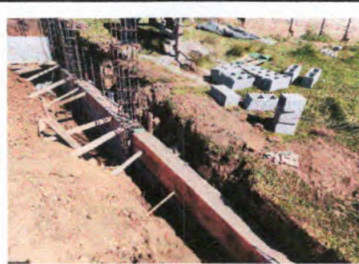
CONSTRUCCIÓN DE MURO DE CIRCULACIÓN
