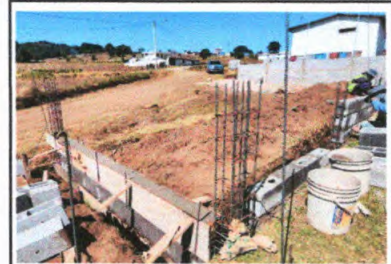
CONSTRUCCIÓN DE MURO DE CIRCULACIÓN
