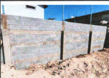
CONSTRUCCIÓN DE MURO DE CIRCULACIÓN
